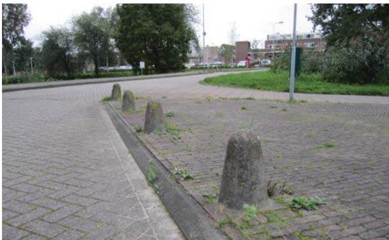
De vlakke onderzijde en het formaat maken dat deze oplossing eenvoudig in elementverharding en stoepen geplaatst kan worden en ook nog (redelijk) valt te beheren.
