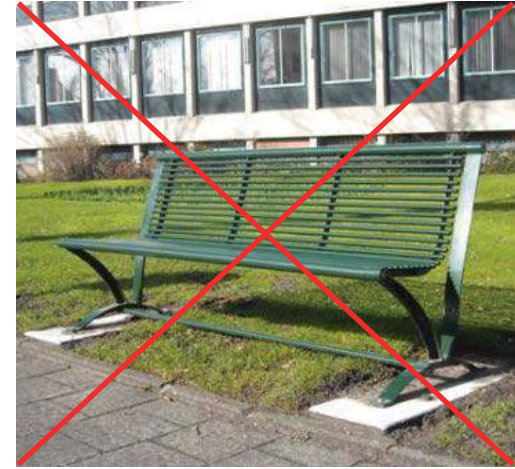
Betonnenvoeten in het gras, zorgen voor een onderbreking van het gras, waardoor de bank op een 'lelijke' manier contact maakt met het maaiveld.
