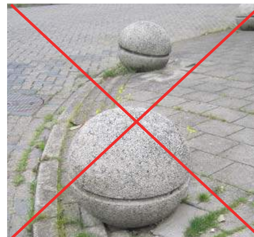
Object is lastig in het beheer, aangezien het onkruid onder de ronde vorm lastig te verwijderen is.
