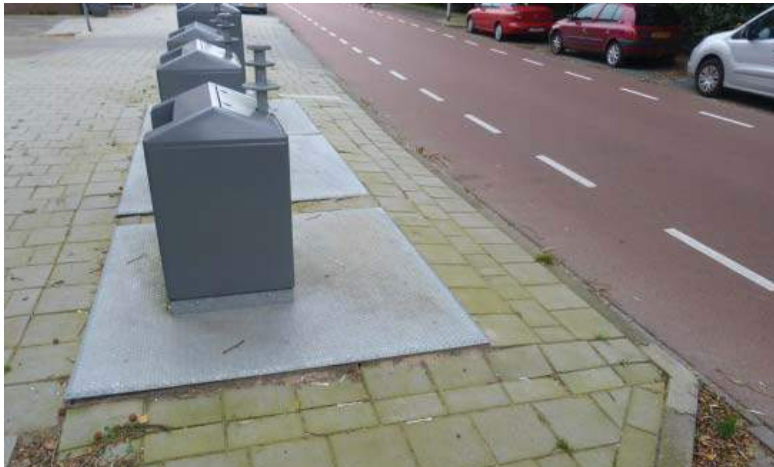
In de lengterichting in het verlengde van langspaarkeervakken is een mooie inpassing.
